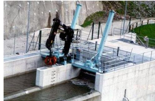
*Dispositivos de limpeza automática de grades finas numa tomada de água na extremidade de um canal*
