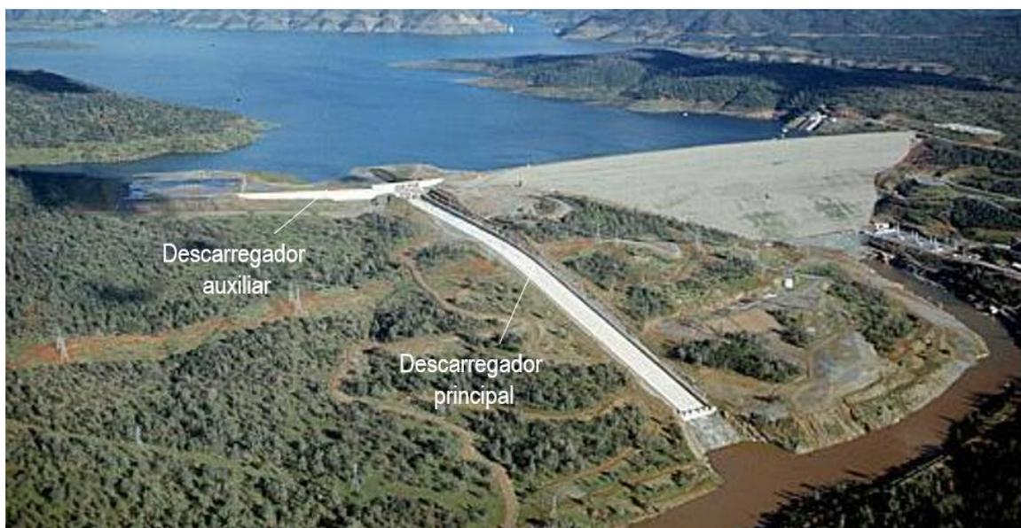
Relativamente ao período de retorno da cheia de projecto, foi apresentado como exemplo o Regulamento Português de Segurança de Barragens de 2016, onde para cada tipo de barragem (de betão e enrocamento com laje a montante ou de aterro) e altura da mesma, é indicado o período de retorno da cheia que deverá ser adoptado. Foi salientado que a cheia de projeto deve ser amortecida na albufeira. Será assim definido o caudal de projecto do descarregador.
