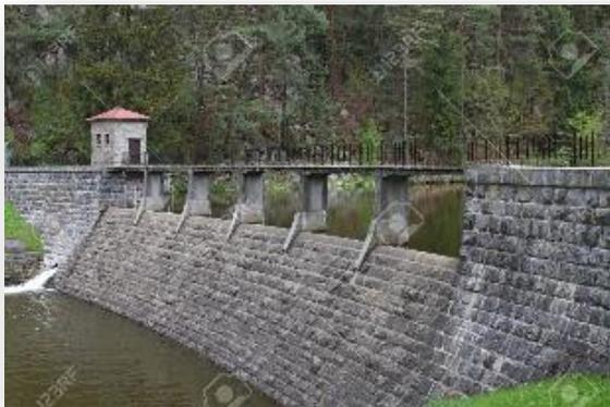
*Barragem de alvenaria de pedra*
