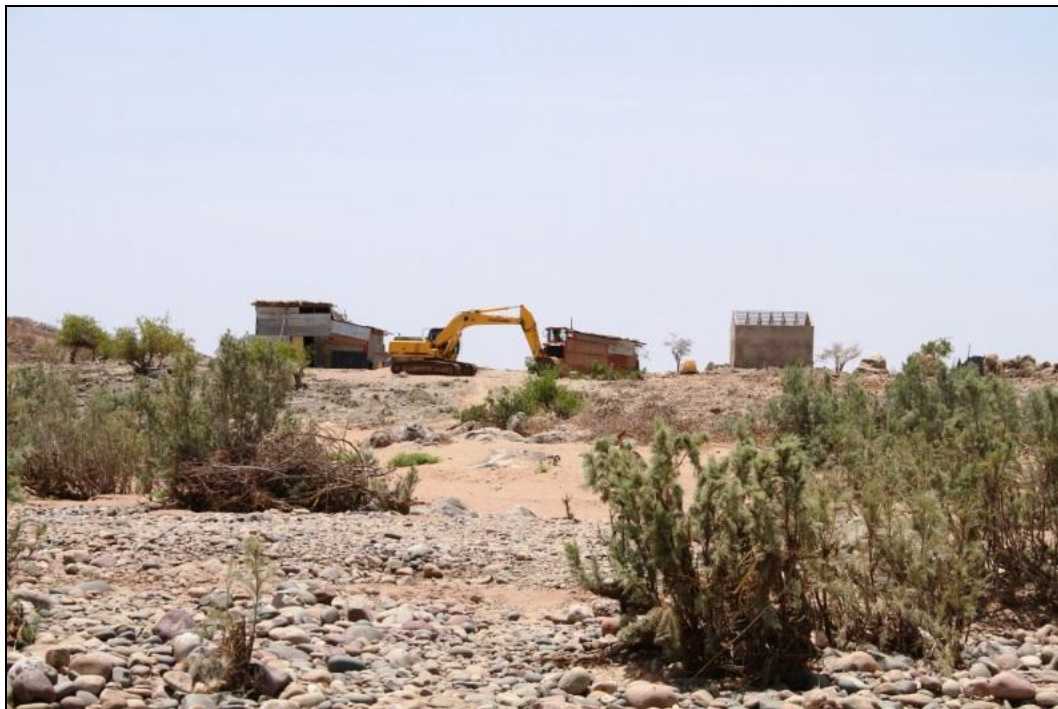
Foto 25.- Acampamento Pediva, Obras do novo acampamento, margem direita do rio Curoca.
