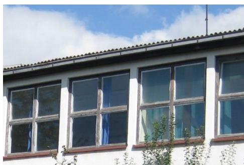
Slika 9. Izgled prozora na glavnom školskom objektu
