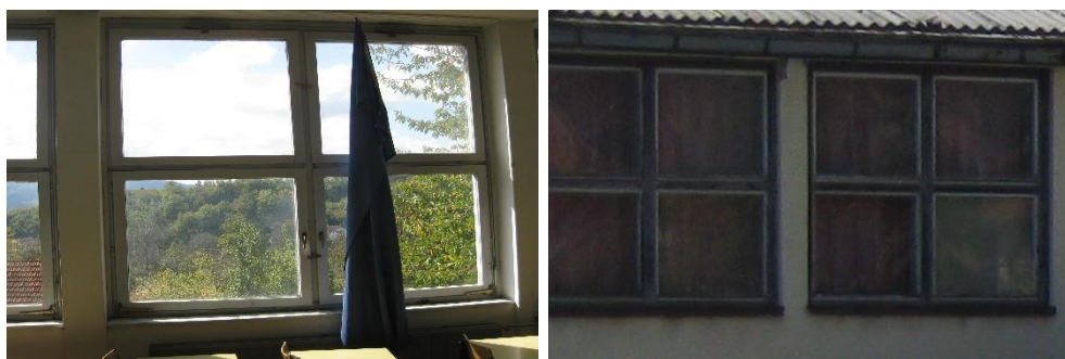
Slika 8. Prozori na glavnom školskom objektu
