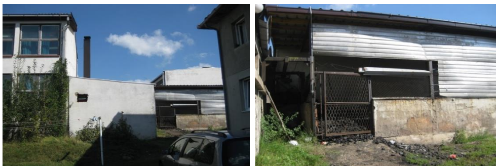
Slika 24. Lokacija kotlovnice (lijevo) i spremište za mrki ugalj (desno)
