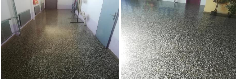
Slika 14. Pod glavnog objekta
