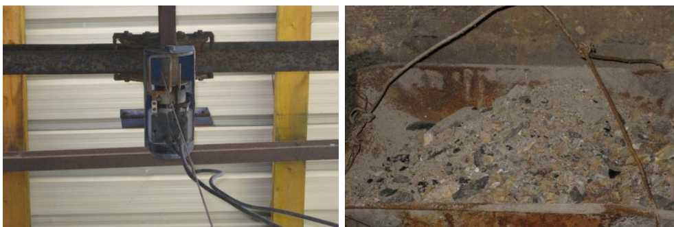
Slika 27. Sistem za izvlačenje pepela
