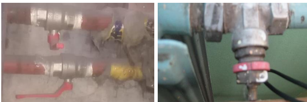
Slika 22. Prikaz regulacionih ventila na grijnim tijelima
