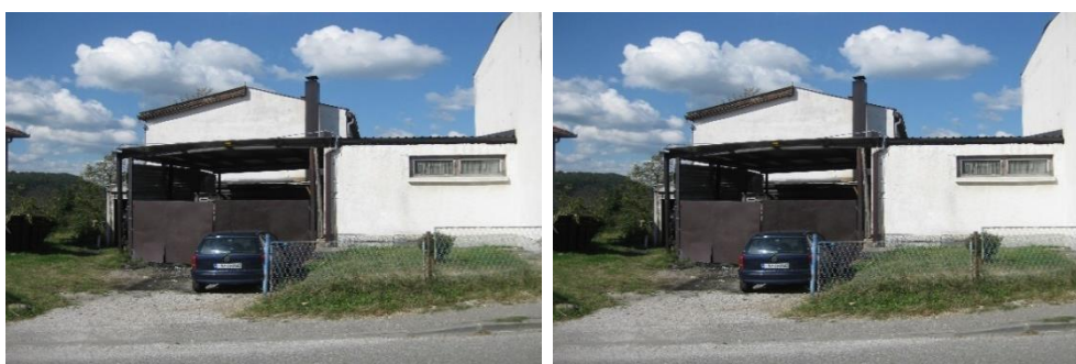
Slika 5: Istočna fasada (lijevo) i južna fasada glavnog objekta (desno)
