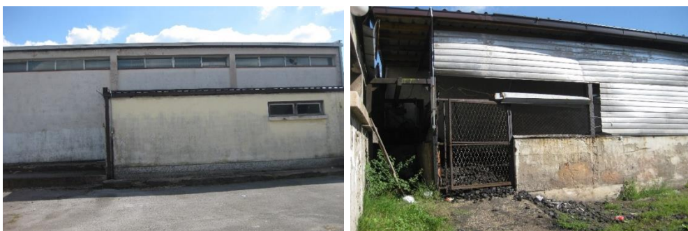
Slika 7. Zapadna fasada fiskulturne dvorane (lijevo) i spremište za ugalj uz južnu stranu fiskulturne dvorane (desno)
