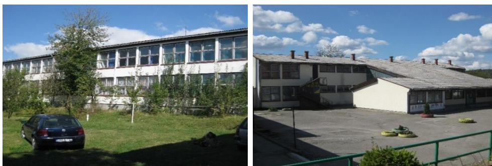
Slika 3: Sjeveroistočna fasada (lijevo) i južna fasada glavnog objekta (desno)
