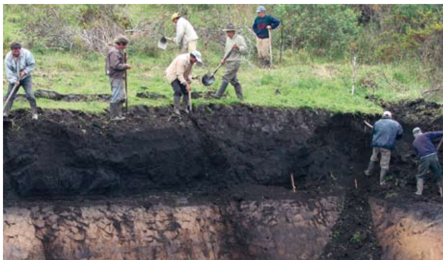
PROYECTO mejoramiento de los sistemas de riego en las comunidades de palo blanco y el empedradillo, cantón mira
