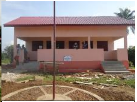
Poste de contrôle de Fangamadou (Gbéssé)
