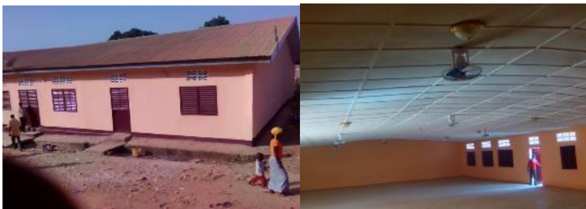
La maison des jeunes de Ouendé Kènèma rénovée
