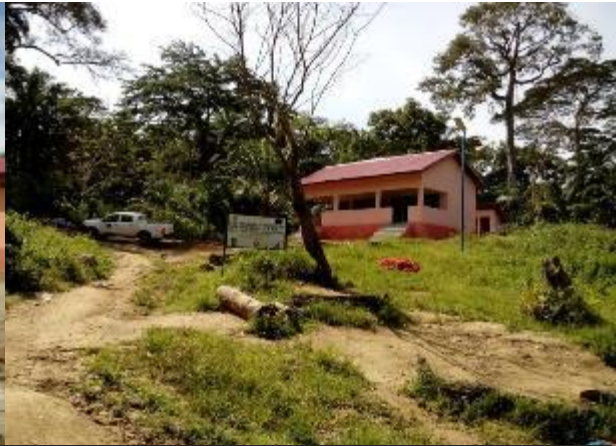
Poste de contrôle de Koundou (Krigbema)
