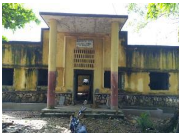
Le Palais de justice de Guéckédou avant la rénovation
