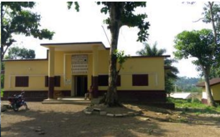
Le Palais de justice de Guéckédou rénové avec latrine
