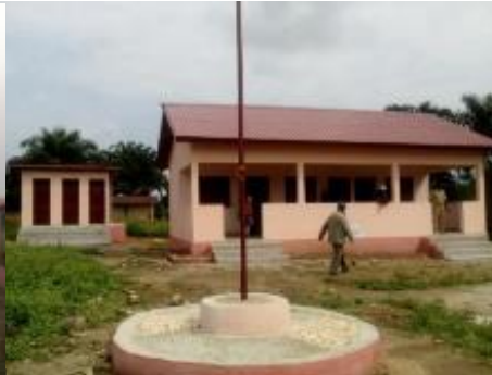
Poste de contrôle de Nongoa
