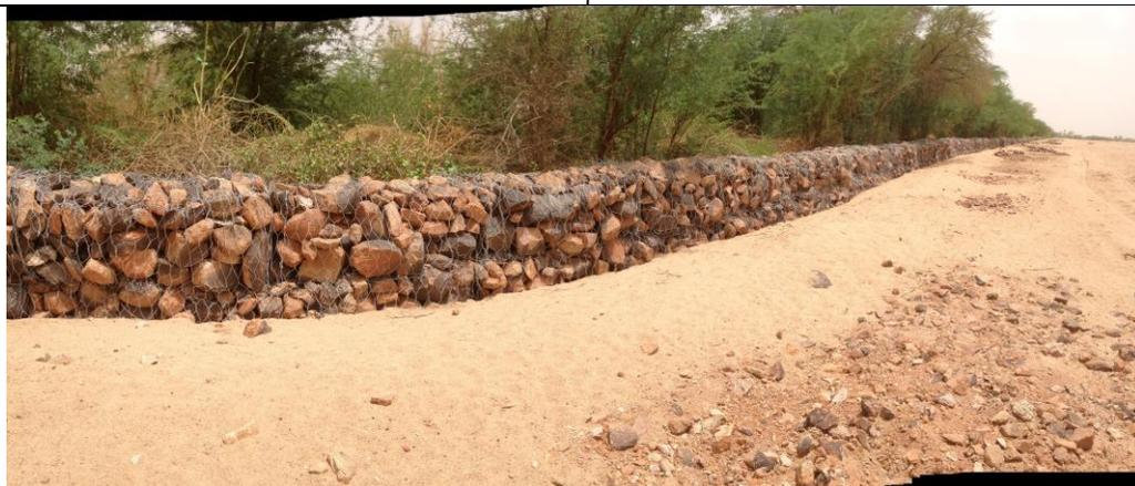
*Photo 19 : Construction de la digue de protection du Kori à Agadez*
