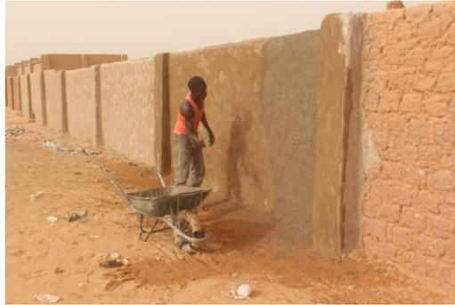
*Photo 7: travaux de crépissage de murs*
