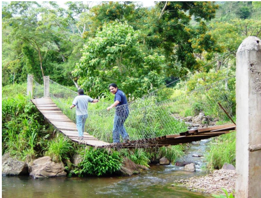
MONITOREO Y SUPERVISION DE OBRAS EN LA ZONA DE PATUCA
