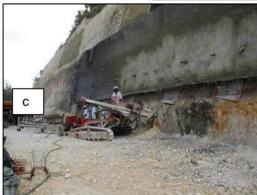
*Exemple de paroi clouée (a) et de différents dispositifs de mise en œuvre : en falaise (b) et au sol (c).*
