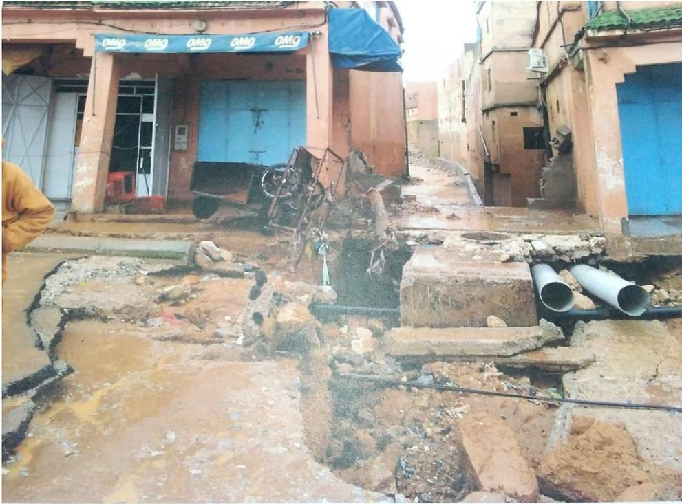
**Figure 9. Photo des canaux d'adduction de l'eau potable dégradés suite aux inondations à la commune de Lakhssas**
