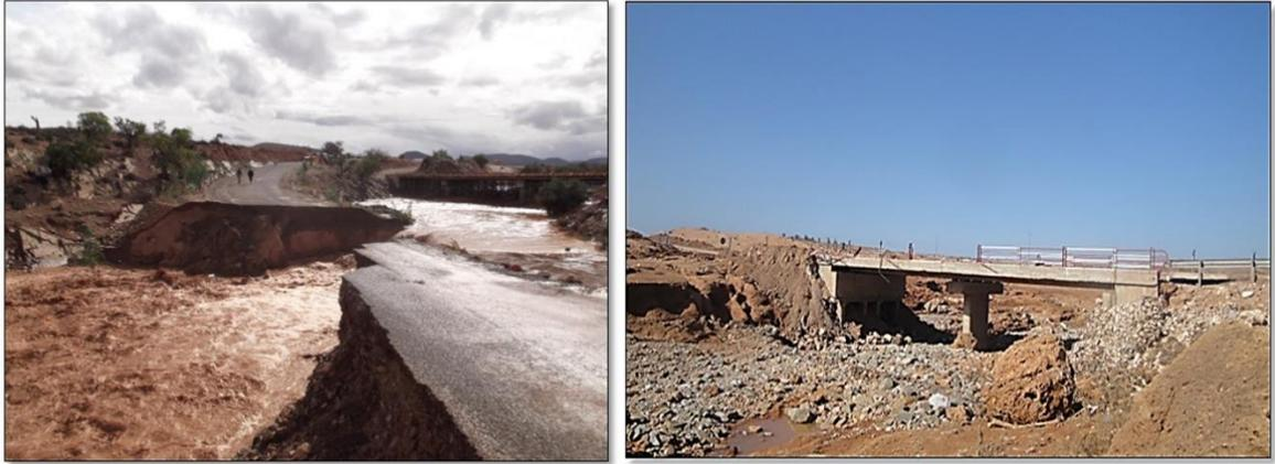
**Figure 8. Photos d'une route emportée (RR104) et d'un pont endommagé suite aux inondations de la province de Sidi Ifni**
