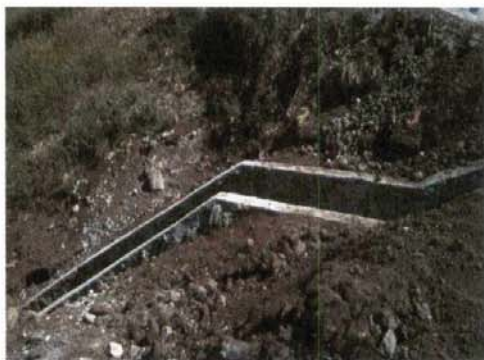
Descargas de mampostería y empedrados fraguados con drenaje superficial San Julián, Sonsonate, Enero de 2015
