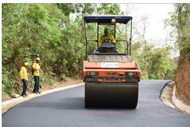
Compactación y sello final de carpeta asfáltica, se observan los drenajes longitudinales incorporados así como la drástica reducción de la condición de polvo en la vía
